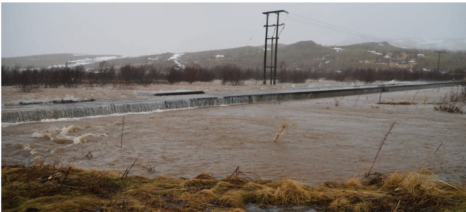
Mynd 12.10. Ofsaflóð í Mosfellsbæ vegna mikillar úrkomu og snjóbráðar, en afrennslið er af landi sem er illa gróið á köflum, og þá aðallega á melum og rofdílum. Takið eftir ísnum í rofdílum neðst fyrir miðju. Horfur eru á að ástandið batni á þessu svæði þar sem landið hefur verið friðað fyrir beit og skógrækt er stunduð á hluta vatnasviðsins.
