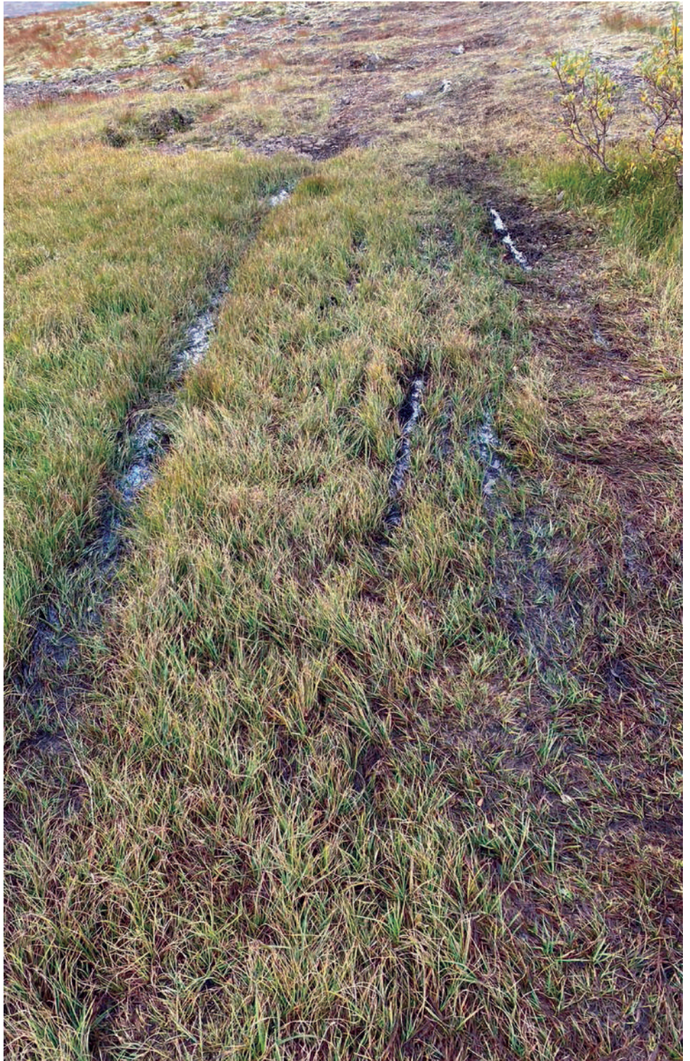
Mynd 12.20. Skemmdir vegna gangandi og hjólandi fólks á fjölfarinni leið yfir votlendiskafla. Stígurinn er farinn að „breiðast út“ með tilheyrandi skemmdum á stóru svæði. Hér væri æskilegt að krækja hjá votlendinu eða leggja timburgólf yfir það. „Betri er krókur en kelda.“
